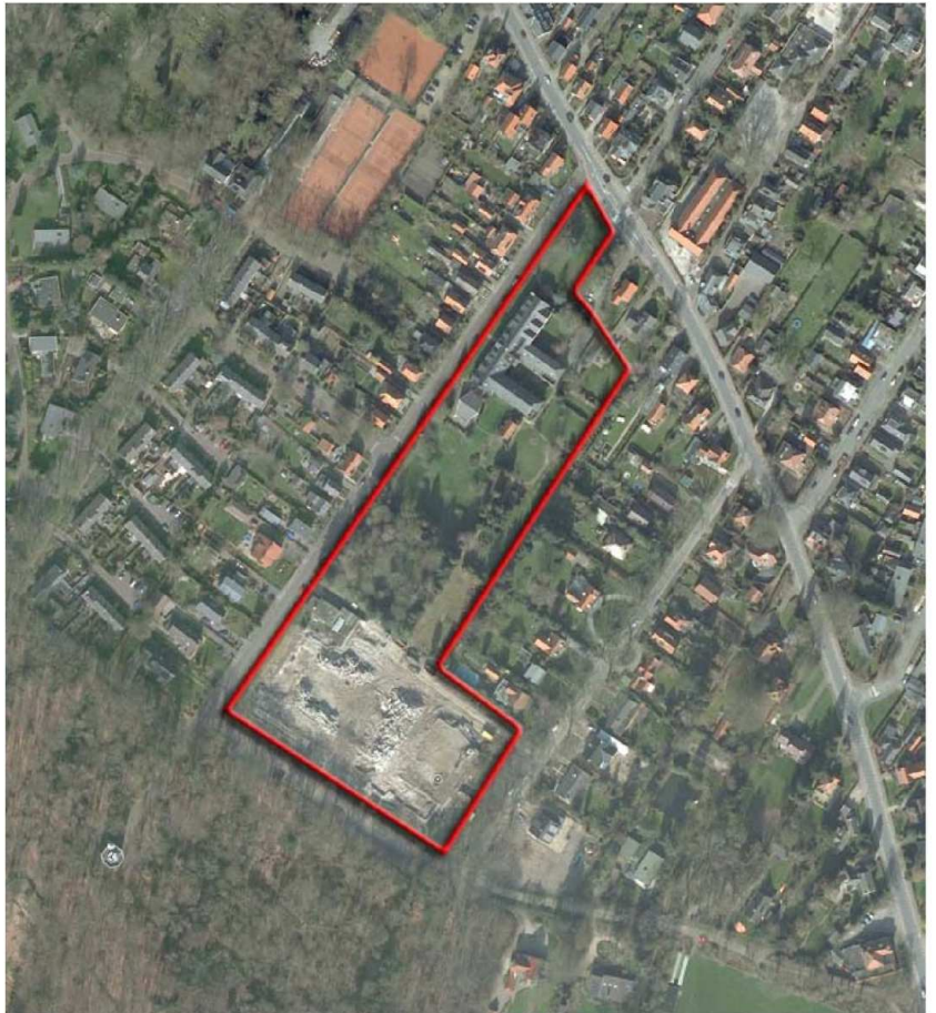
Luchtfoto plangebied waarop de gebouwen van het Staring College zijn gesloopt
