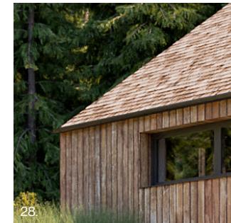
28. Platte dakpannen, kleur afgestemd op de gevel
