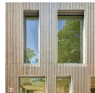
31. Details van de gevels - meer diepte en ritme op de gevel
