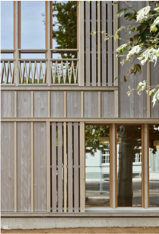
18. Verfijnde details van de gevel met duidelijk onderscheid van de verdiepingen
