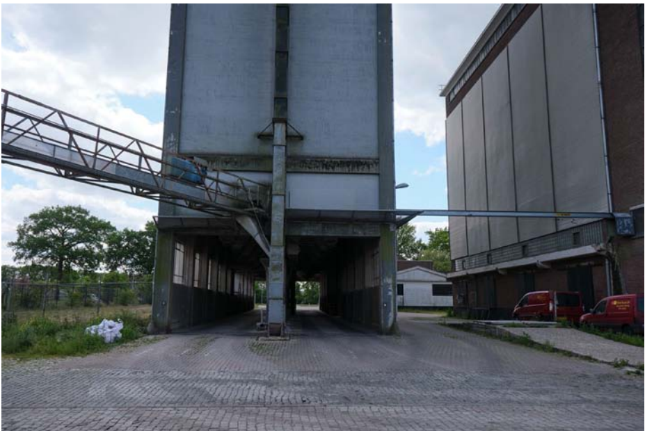
Silo's van OOCON gezien vanaf zijde Twentekanaal
