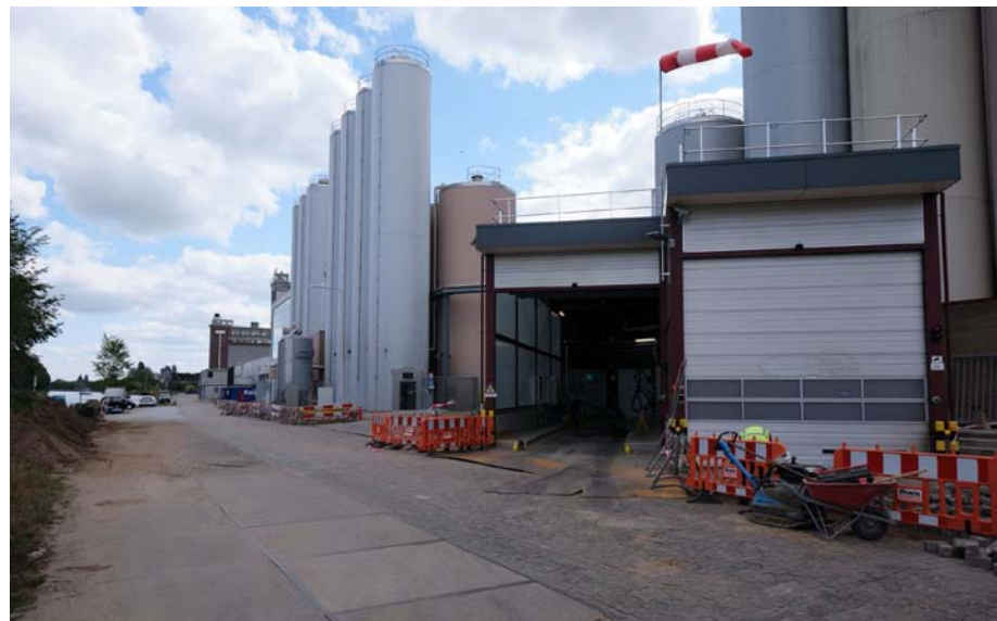
Havenstraat met rechts silo's van FrieslandCampina
