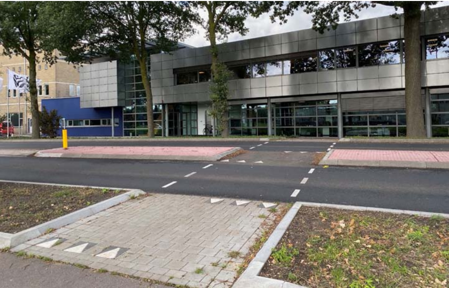
Recent gerealiseerde voetgangers oversteekplaats ter hoogte van Wila
