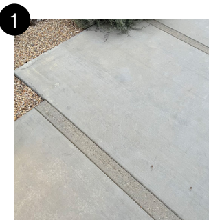
Trottoir in de voortuinen uitvoeren in betonplaten (bijv. lichtgrijs)
