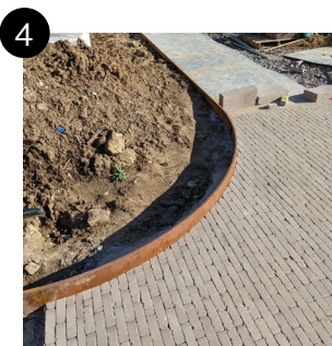
Klinkerpad opsluiten met cortenstaal waar mogelijk
