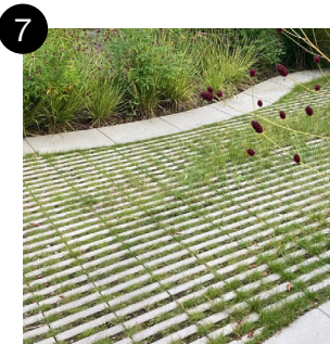
Waterpasserende verharding parkeervakken en bermen
