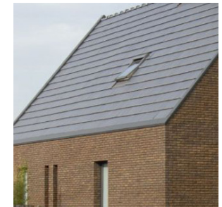
Platte dakpannen, kleur afgestemd op de gevel
