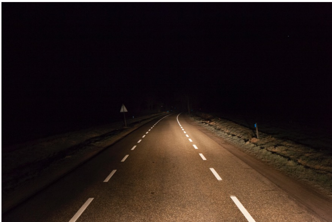
Foto: Zwiepseweg in Barchem. Belijning die reflecteert waardoor het verloop van de weg goed te zien is.
