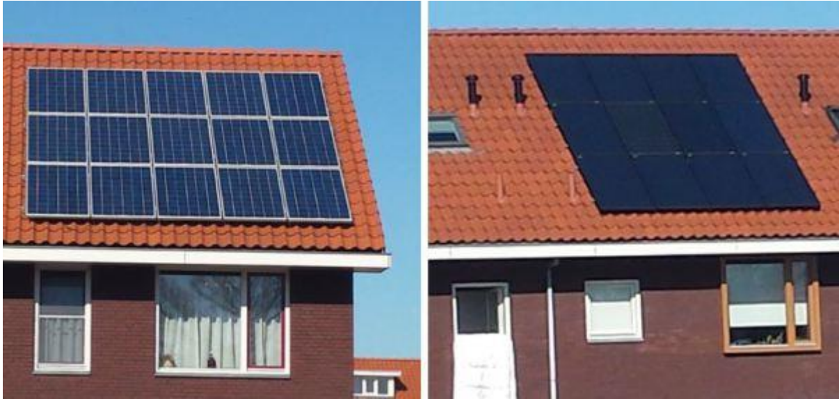
Links polykristallijne zonnepanelen, rechts de monokristallijne zonnepanelen.
