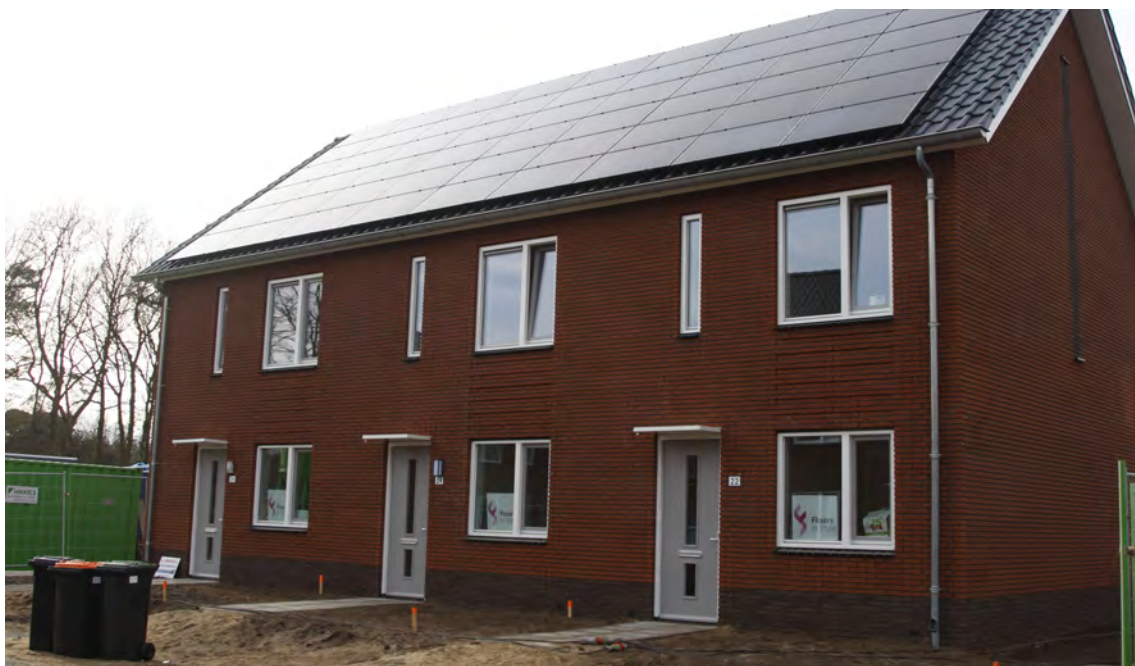
Nieuwbouw sociale huurwoningen Harfsen
