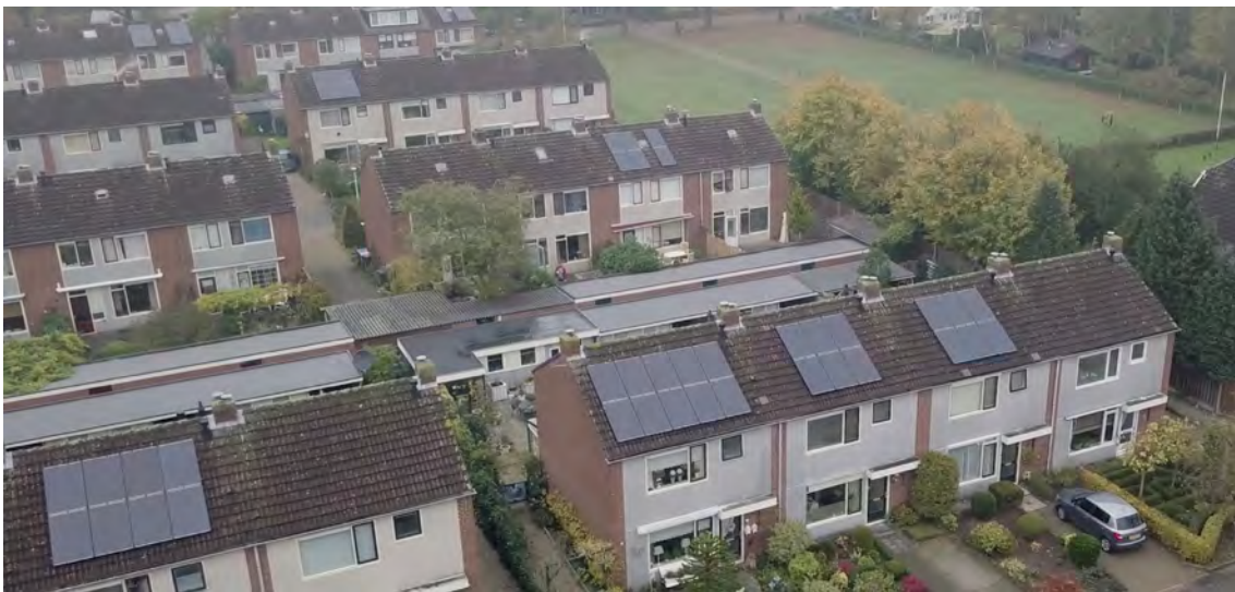
Zonnepanelen op huurwoningen IJsseldal Wonen
