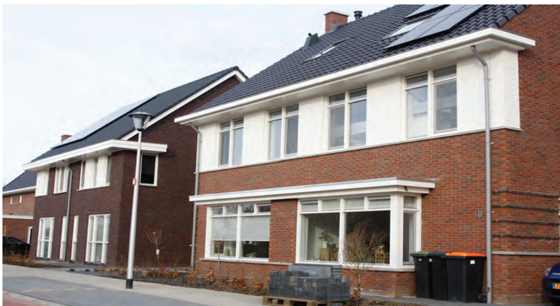
Twee-onder-een-kap woningen Waterdijk-West Epse
