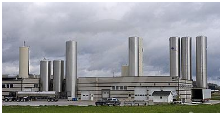
Industriële uitstraling door gebruik van stalen silo's
