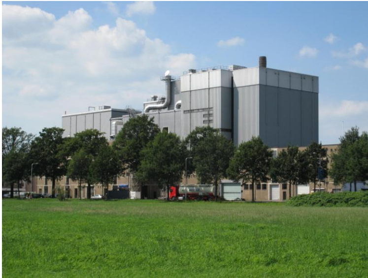
Bestaande situatie gevel Goorseweg FrieslandCamping. Onder 15 meter stenen gevel en terugliggend tot 35 meter damwandprofielen
