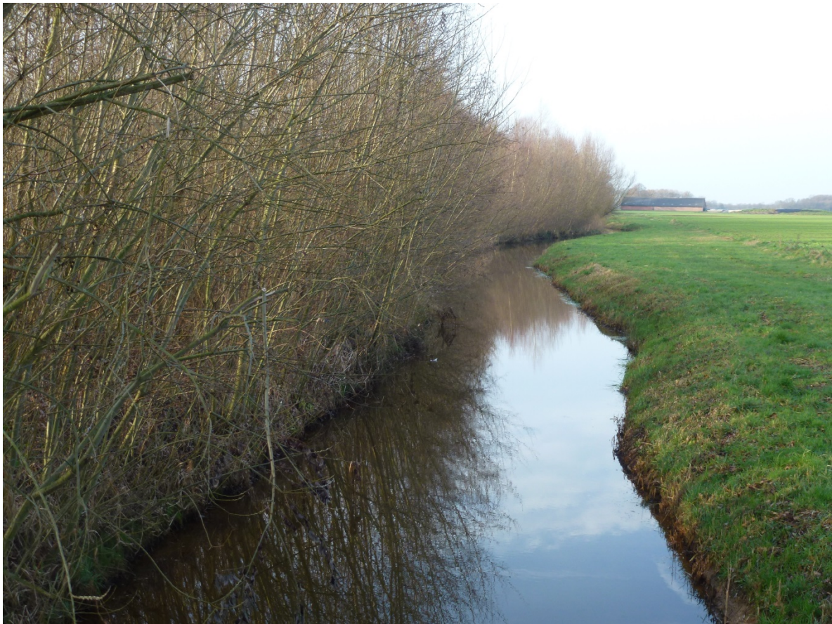
Figuur 3.10 Voorbeeld van een situatie in het beheergebied van het Waterschap Rijn en IJssel van een beekbegeleidende elzensingel op de zuidoever van een watergang met een 'eenzijdig' onderhoudspad van circa 4 meter.
