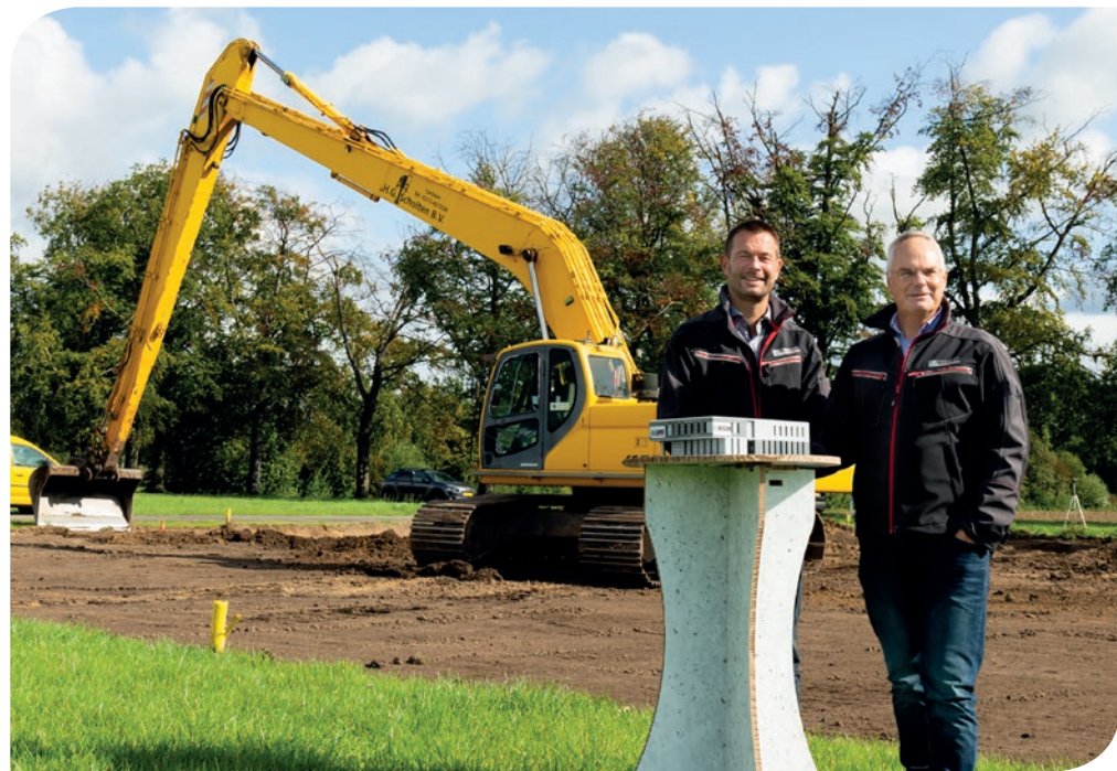
Bedrijfsleider Erwin Rouweler (links) en directeur Johan Olthoff (rechts) van OLBECON tonen een maquette van hun nieuwe kantoor op bedrijventerrein Stijgoord terwijl de graafwerkzaamheden in volle gang zijn. (foto: Gerard Makkinga)
