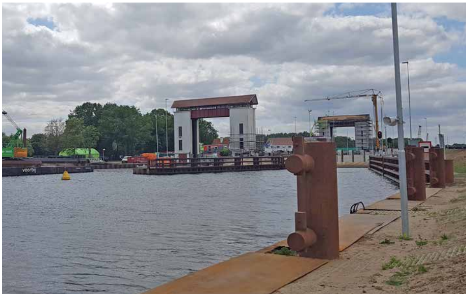
1 | Zicht op het sluiscomplex vanuit het noordoosten
