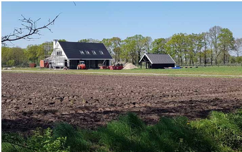
1 | De woning in aanbouw
