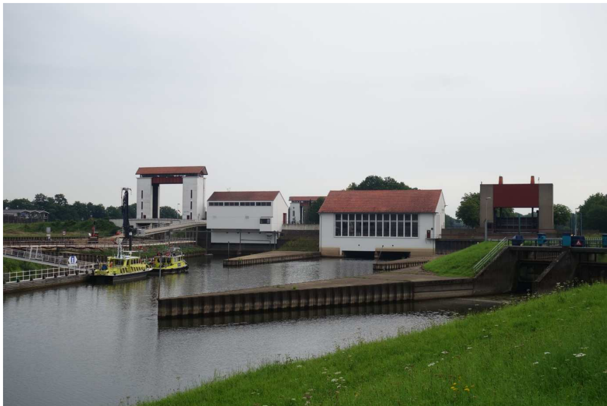
Figuur 92. De Eefdesesluis in het Twentekanaal dateert uit de jaren 30 (foto: CeesJan Frank).
