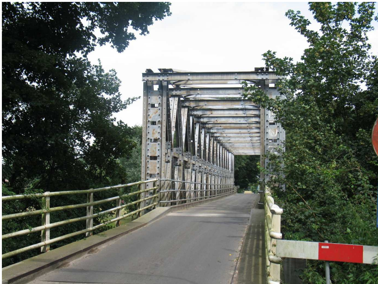
Figuur 70. IJzeren Kanaalbrug bij Almen. Deze zogenaamde Baileybrug werd kort na de bevrijding gebouwd ter vervanging van de gesprongen brug (foto: CeesJan Frank).
