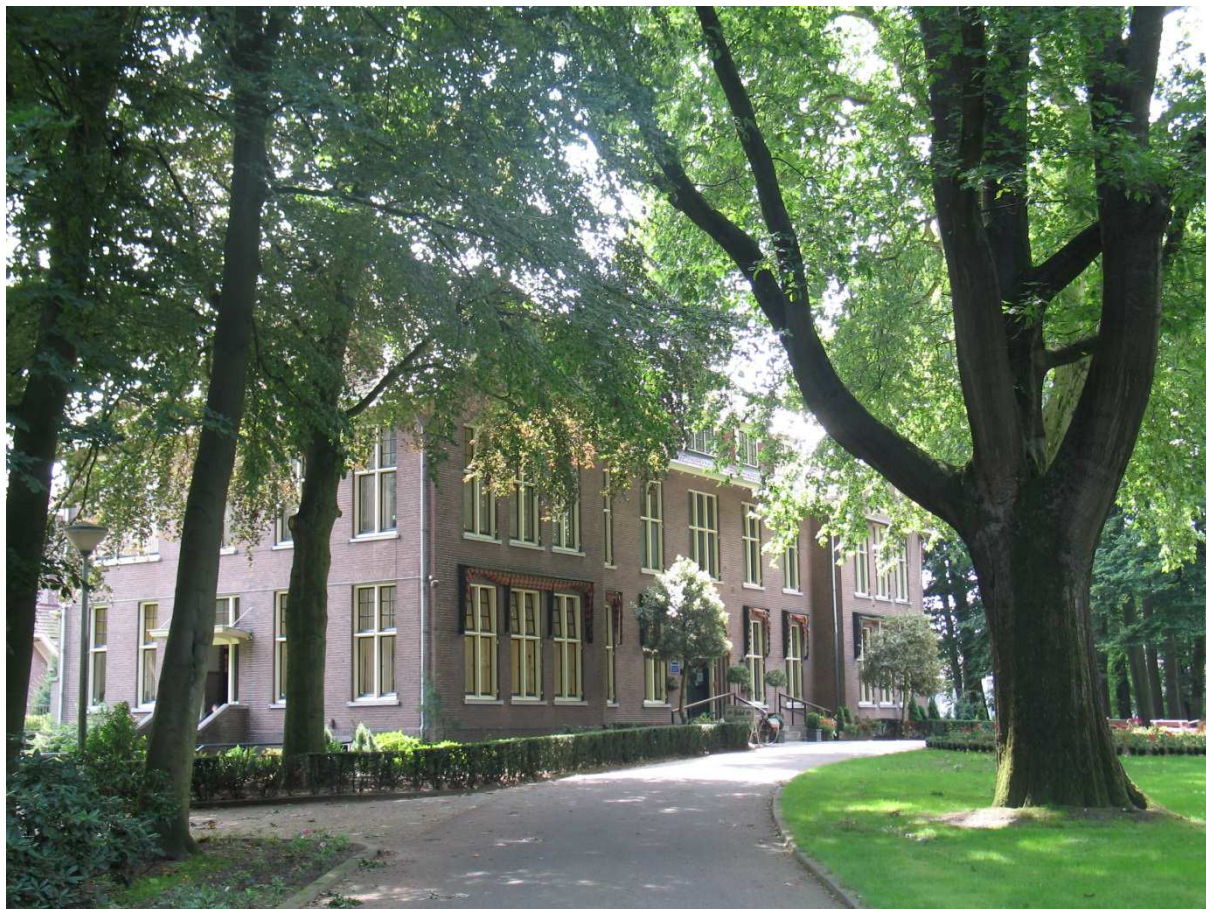
Figuur 87. Het voormalige P.W. Janssenziekenhuis in Almen (foto: CeesJan Frank).
