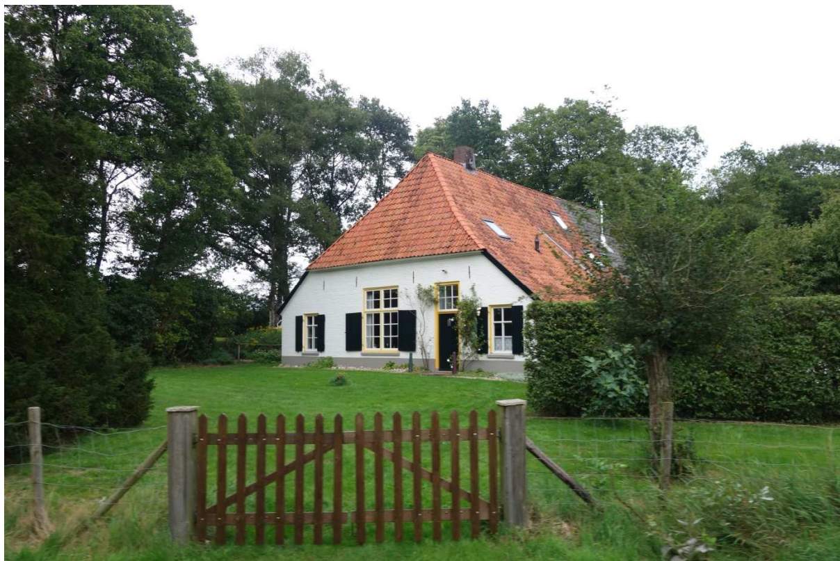
Figuur 47. Oude hallenhuysboerderij met gebintconstructie op de Barchemse enk (foto: CeesJan Frank).
