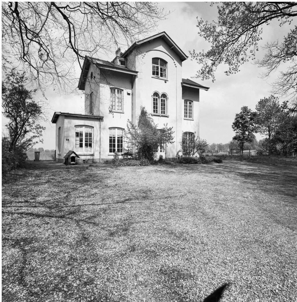
Figuur 93. Het voormalige station Harkelbrug, halteplaats voor Laren en Almen, uit 1865, gefotografeerd in 1999 (bron: Rijksdienst voor het Cultureel Erfgoed).
