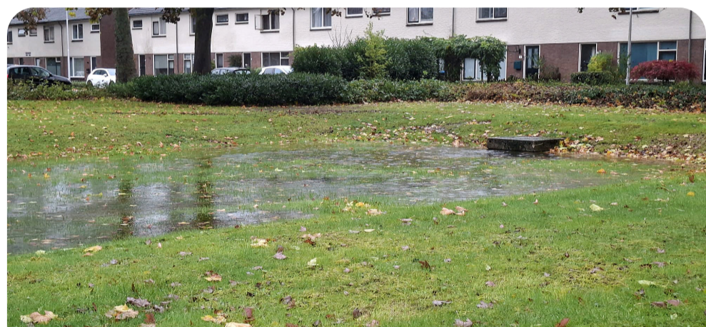
Wadi hoek Henry Dunantweg - Albert Hahnweg. Een wadi (waterafvoer, drainage en infiltratie) is een verlaagd, groen gebied, zoals een greppel of gazon, dat dient als tijdelijke opslag- en infiltratievoorziening voor regenwater.
