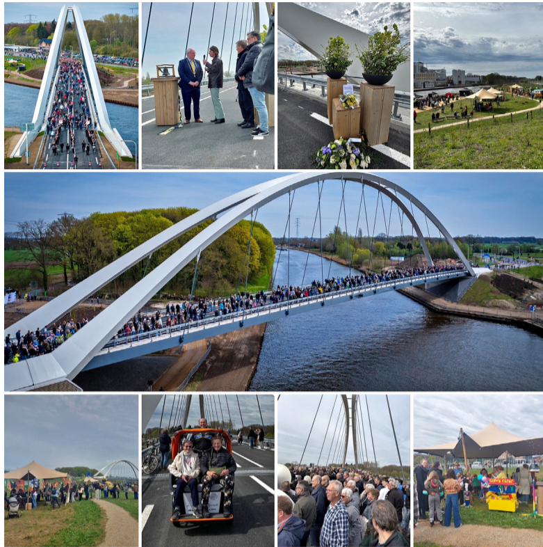
De opening van de Nettelhorsterbrug in vogelvlucht. Dronebeelden: provincie Gelderland.
