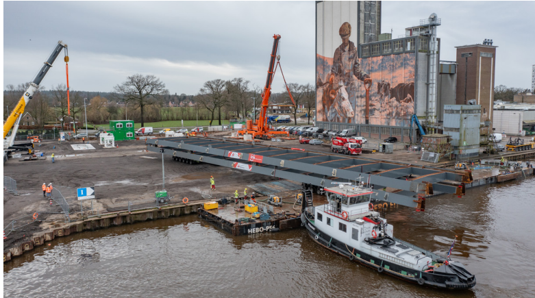
De eerste lading kwam vorige week aan in Lochem. Het ging hier om het stalen brugdek.
