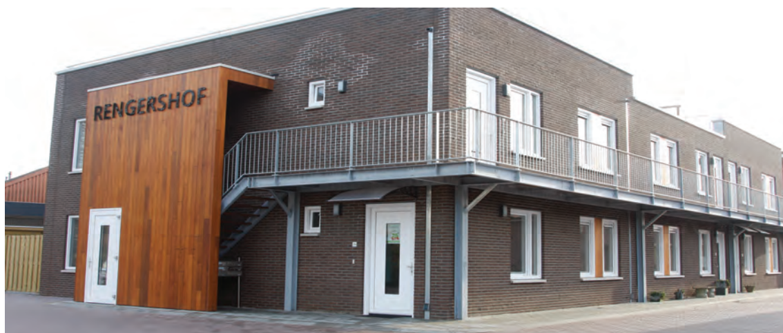
Huurappartementen Rengershof Laren
