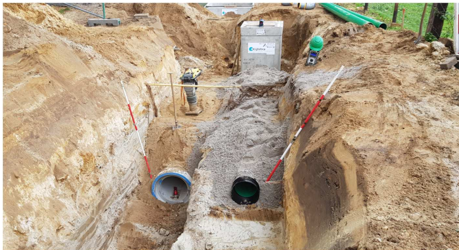
Figuur 15 De aanleg van een gescheiden rioolstelsel
