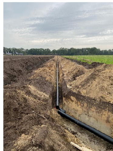
Figuur 7 Reconstructie persleiding Lochem
