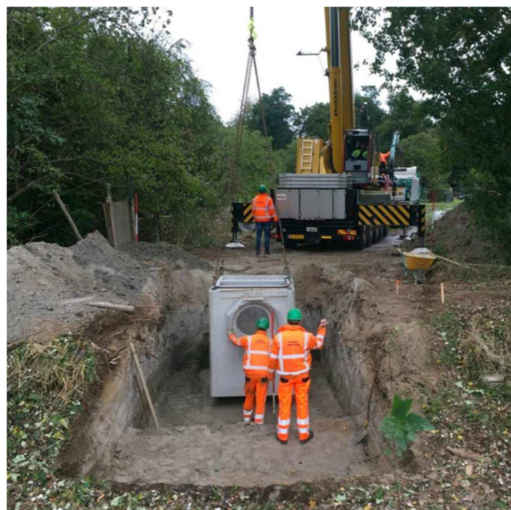
Figuur 17 Het plaatsen van een rioolput
