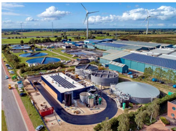
Figuur 4 Rioolwaterzuiveringsinstallatie Zutphen
