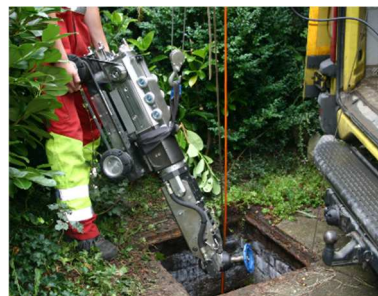
Figuur 18 Rioolinspectie middels rijdende camera
