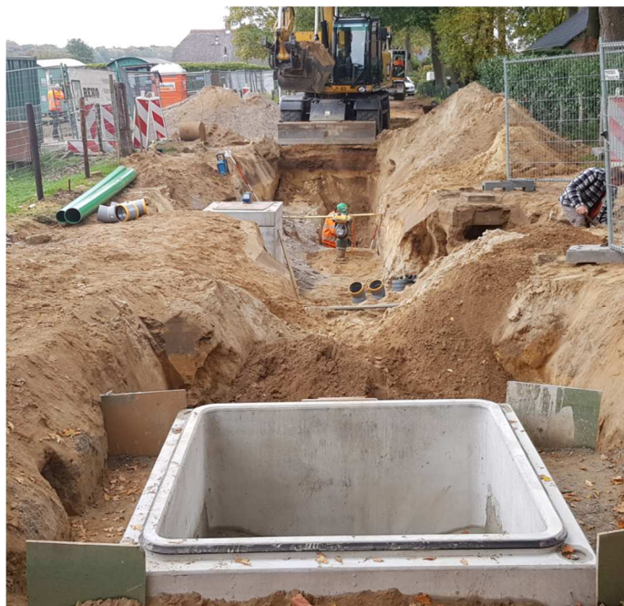
Figuur 23 Riolvervanging, werk in uitvoering
