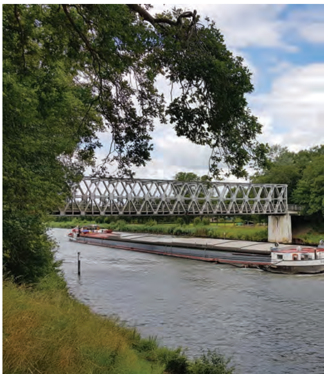
Ezherbrug over het Twentekanaal bij Almen
